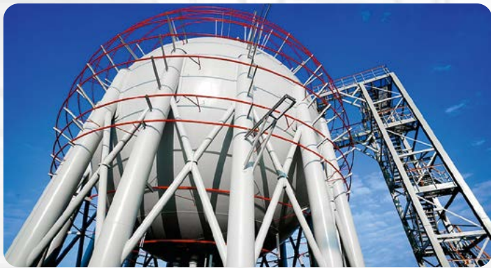
Шаровые резервуары объемом 5 000 куб. метров для ЗАО «Таманьнефтегаз», 2018 г.
